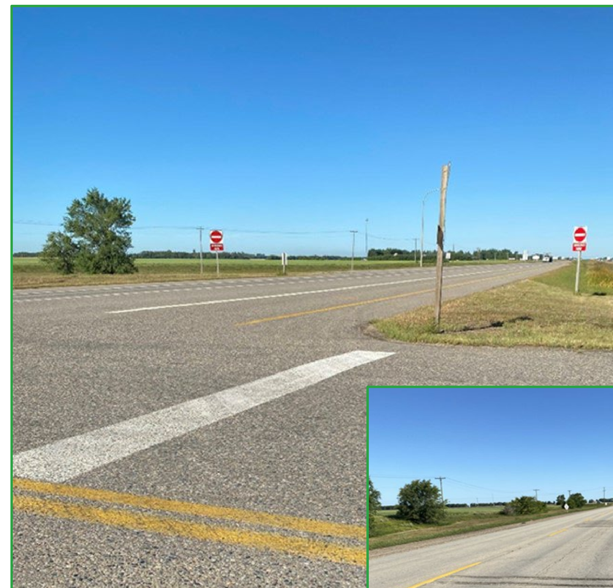
Marques routières remises en état à l'intersection.
