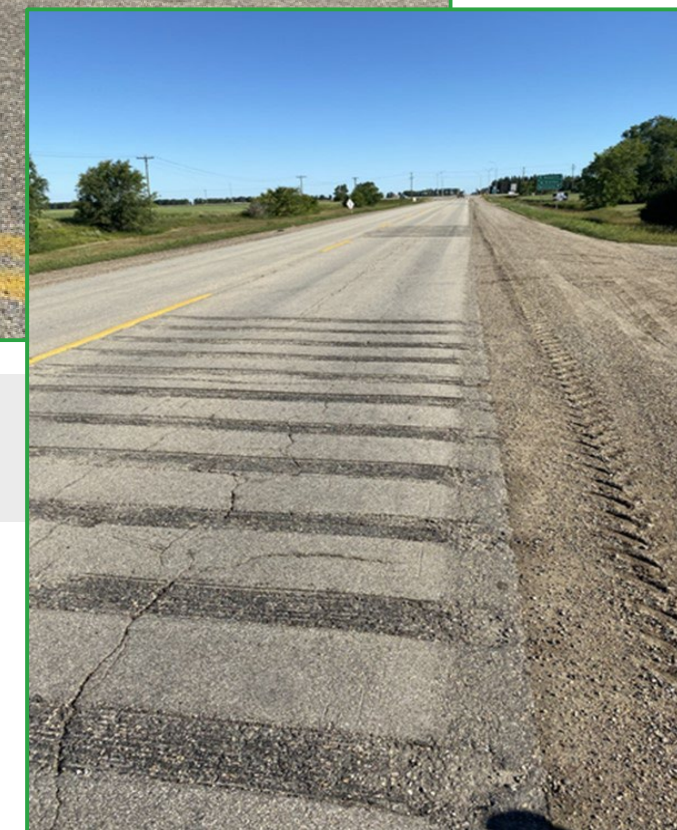
Ralentisseurs sonores remis en état en direction nord et sud.
